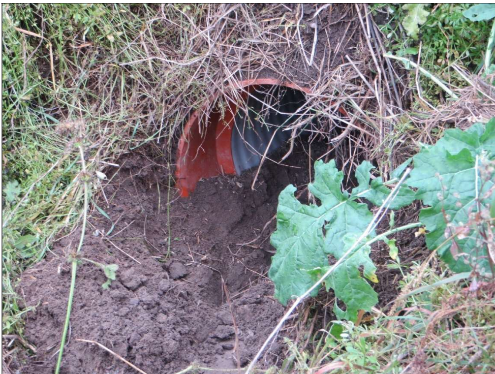
Zdjęcie nr 7. Widok zamulonego przepustu Ø500 na rowie melioracyjnym R-D na wysokości działki nr 11, obręb : Stare Budy Witoldów.
