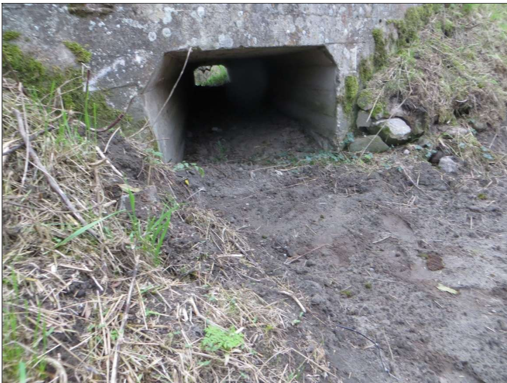
Zdjęcie nr 5. Widok na zamulony przepust ramowy drogowy na wysokości działki nr 2, obręb : Stare Budy Witoldów, na wysokości drogi powiatowej nr 2142E.
